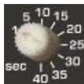
Регулятор задержки переключения контакторов (переключателя) основной либо резервной сети.
